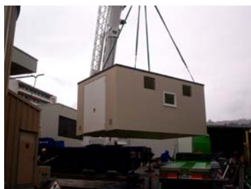
Déchargement d'un local spécialement conçu pour le CCF sur une place aménagée.
